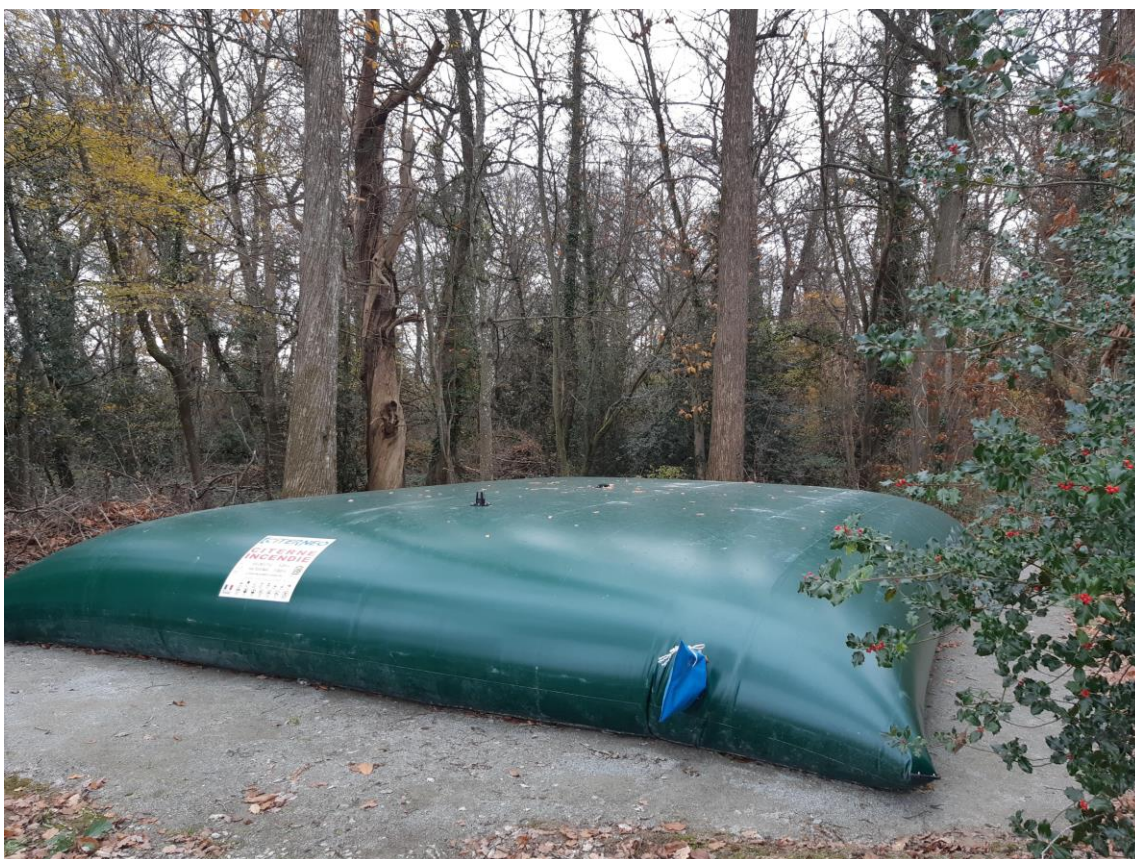
© Réserve incendie CITERNEO de 120 m 3
