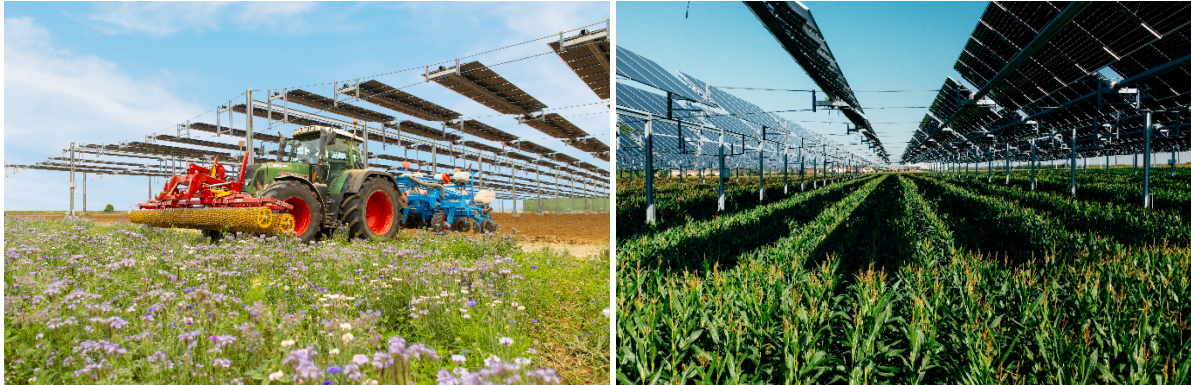
La deuxième canopée agrivoltaïque TSE équipée d'un système d'irrigation intelligent, inaugurée en septembre 2023 à Brouchy (Somme).
